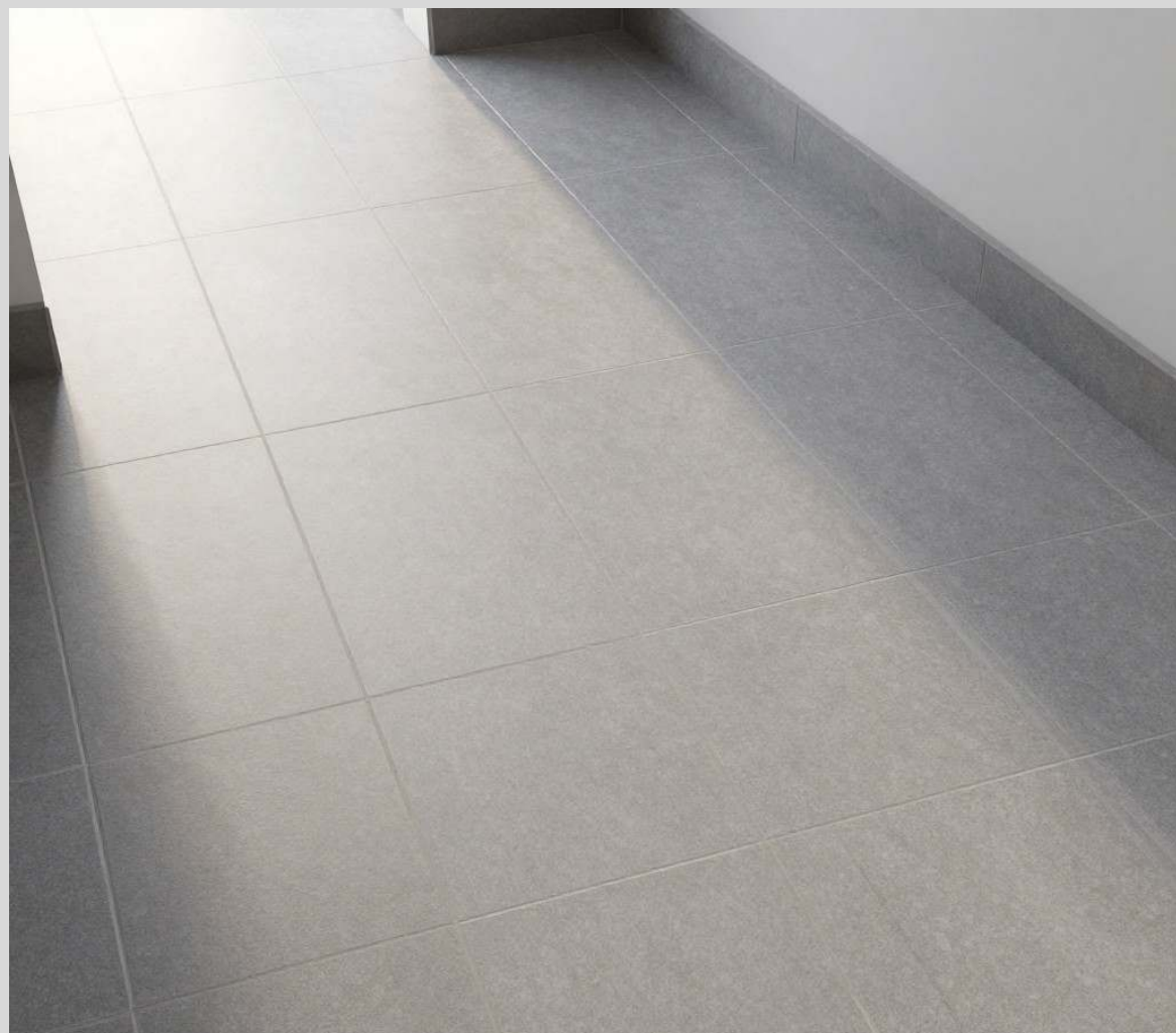
Плитка на полу
