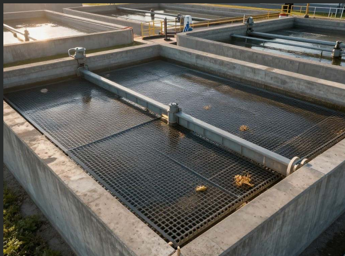
Очистные сооружения в работе
