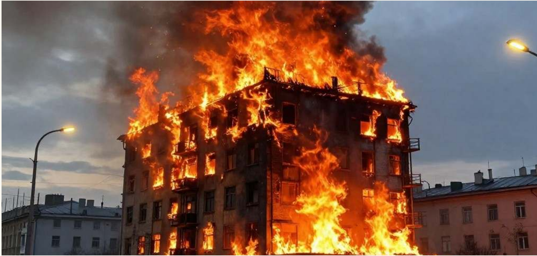
Здание горит: реальное состояние аллайт
